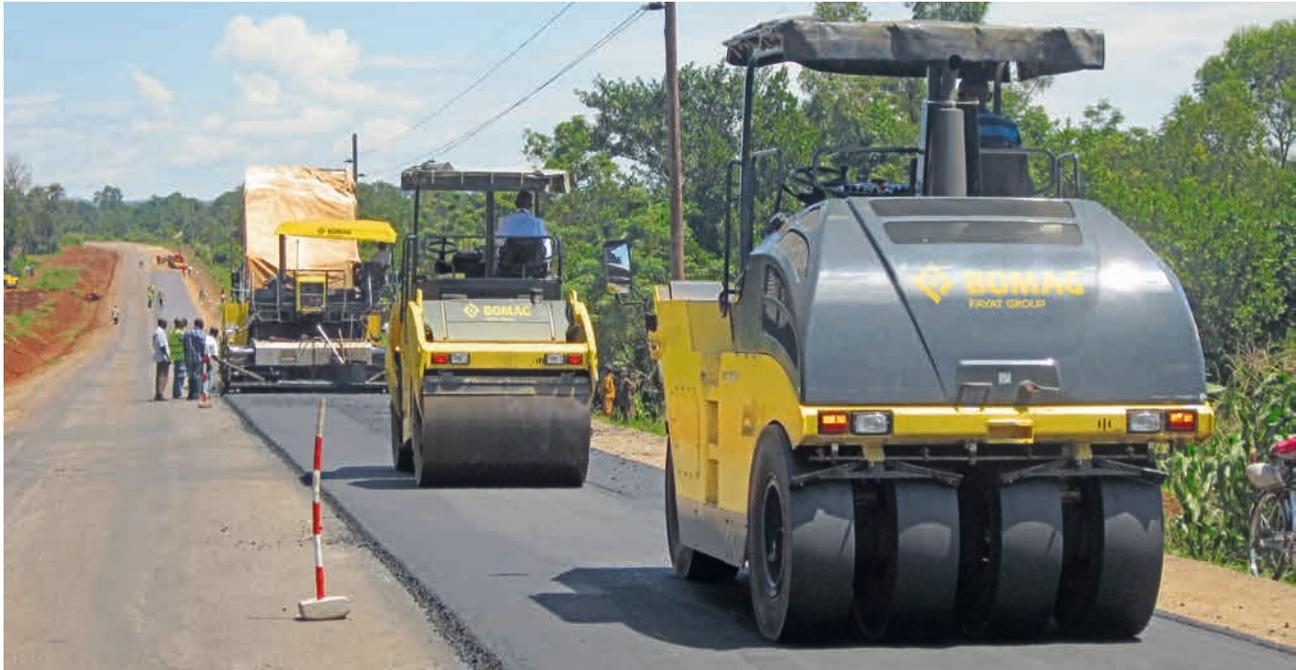
El rodillo BOMAG BW 24 RH compactando asfalto en Uganda.
